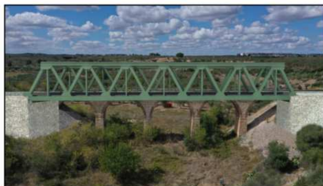
Ponte in acciaio di colore verde a travatura reticolare con impalcato a via inferiore
