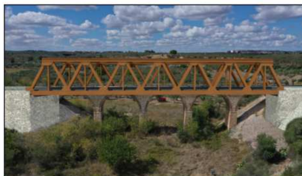
Ponte in acciaio corten a travatura reticolare con impalcato a via inferiore
